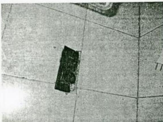
En la foto se muestra toma corriente sin tapas y cables a la vista.
